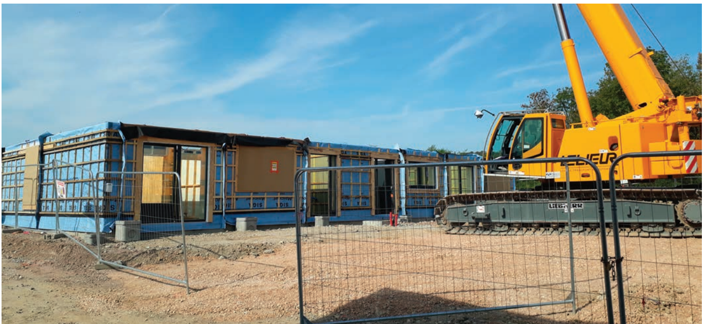
Construction d'un béguinage de 8 logements individuels, à destination des personnes âgées, à Quesques (Pas-de-Calais), par la Foncière Chênelet, avec maîtrise d'usage animée par Béguinage et Compagnie.
